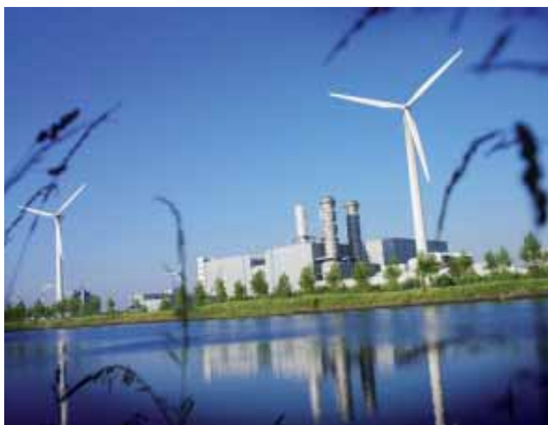
Centrale TGV (Turbine gaz-vapeur) de Herdersburg (Belgique)
