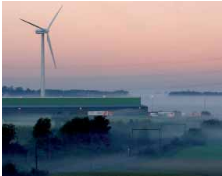
Première éolienne Colruyt au parc industriel «Dassenveld» à Halle
