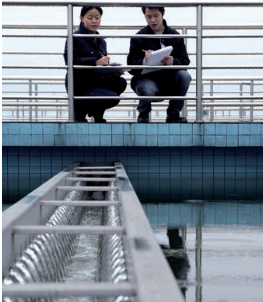
Chine - Chongqing - Usine de production d'eau potable
